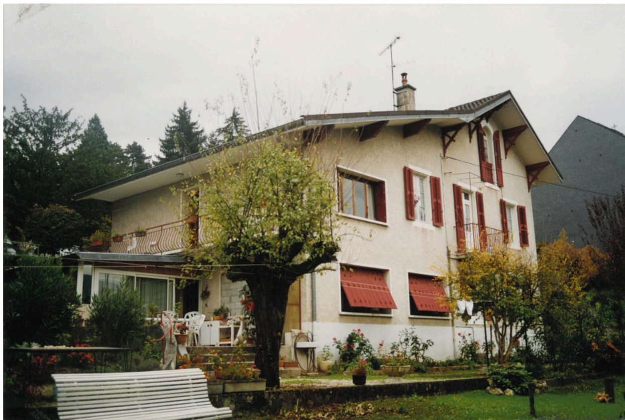
Vue de trois-quart depuis le nord-ouest (photographie, 2001)
