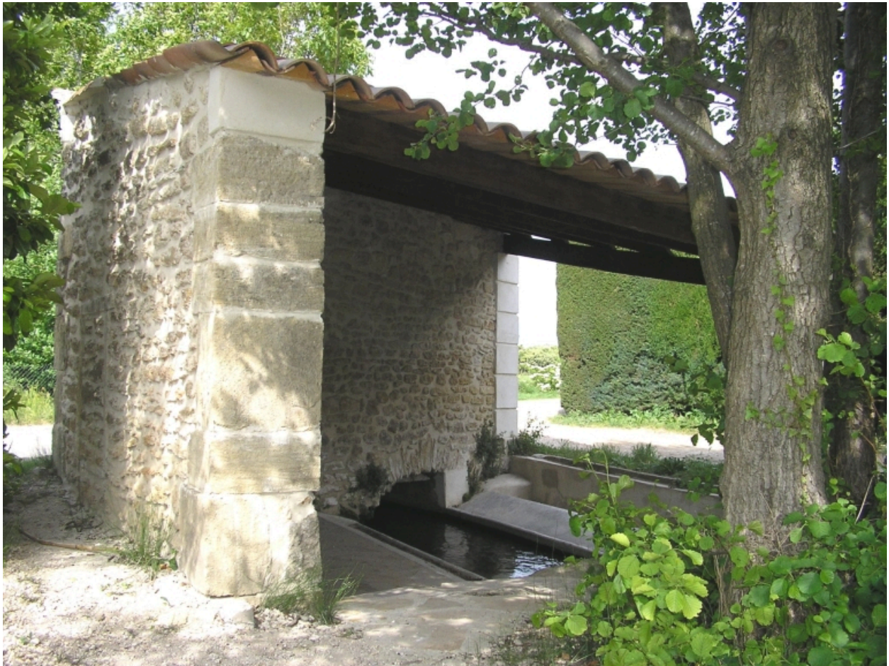
Margerie ; route de Richerenches, vue nord-est du lavoir (C3 729)
