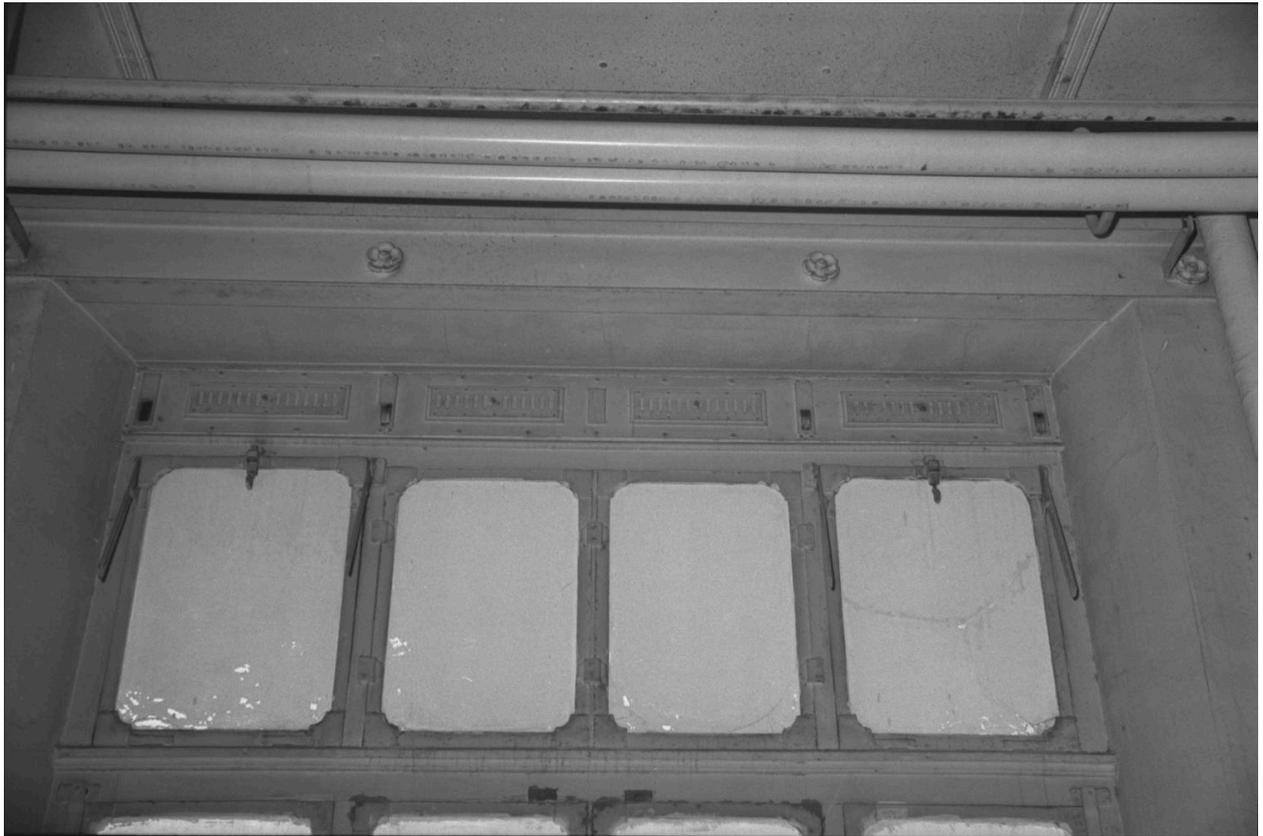
Fenêtres supérieures oscillantes. Linteaux en fer; rosaces en fonte. Bâtiment C, 1er étage, mur ouest
