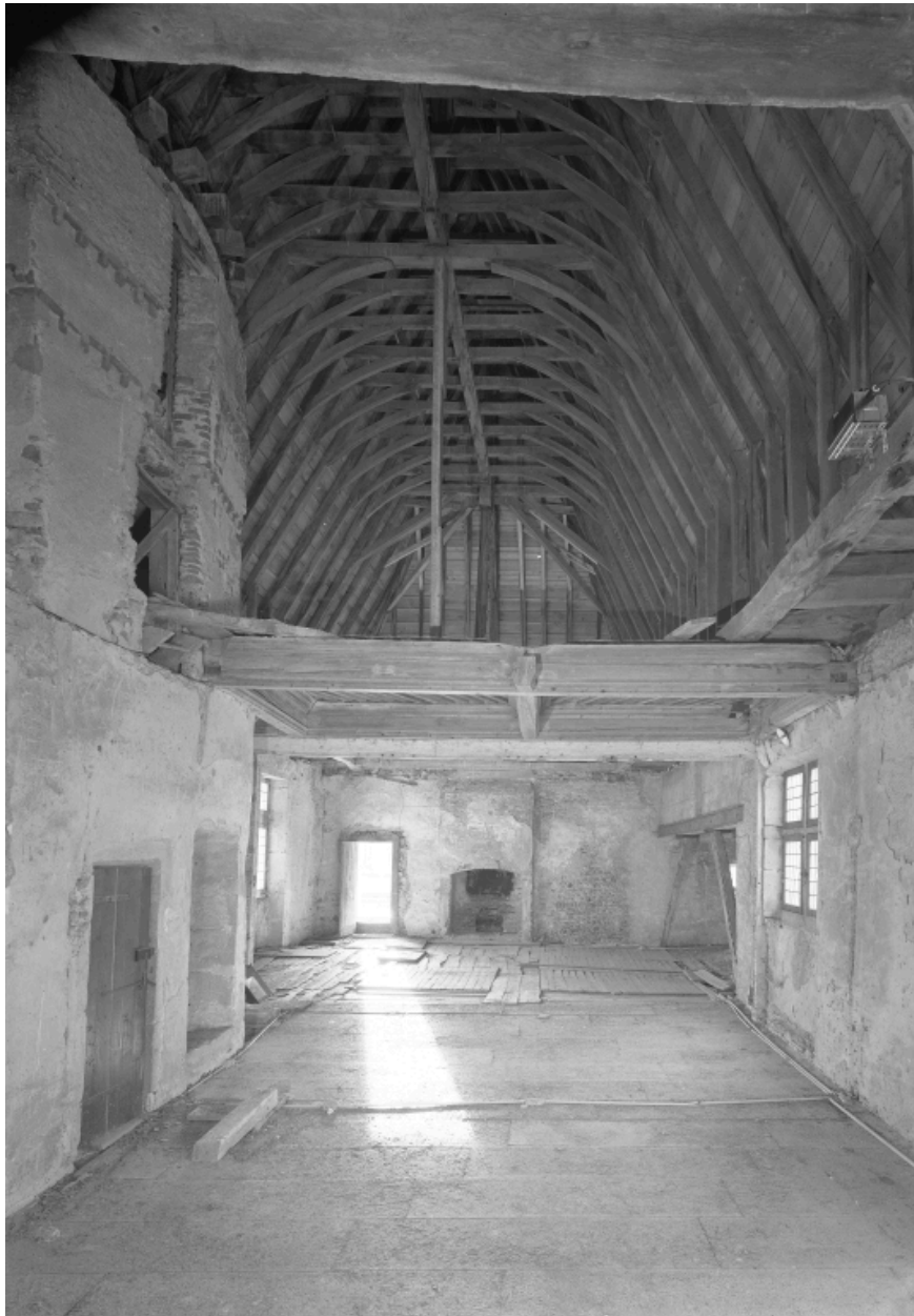
Corps de logis, deuxième étage : vue générale de la cinquième pièce (d'est en ouest) et des vestiges du plafond dit "à la fougère", de l'est.
