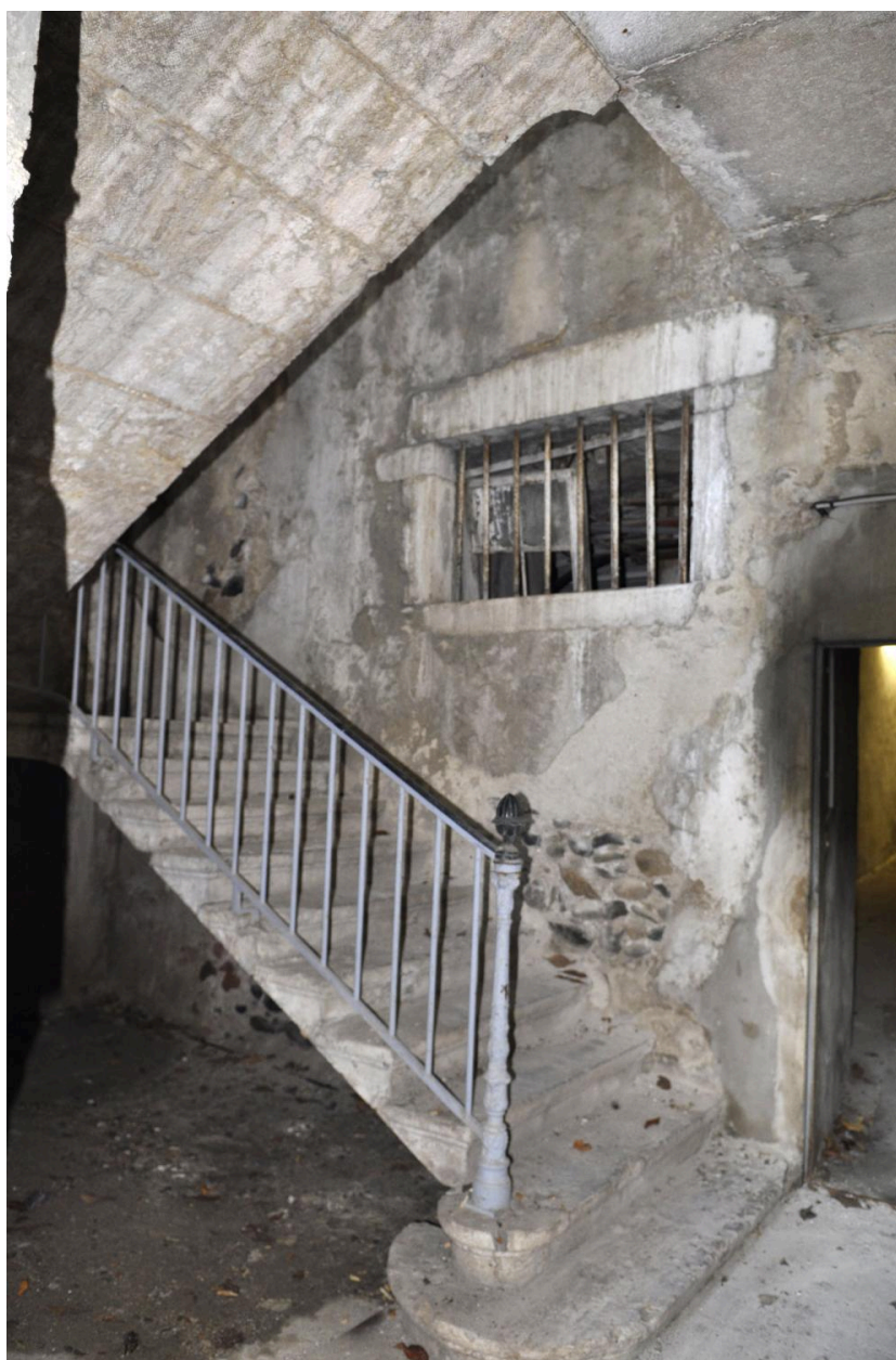
Escalier suspendu à retours (vue d'intérieur)
