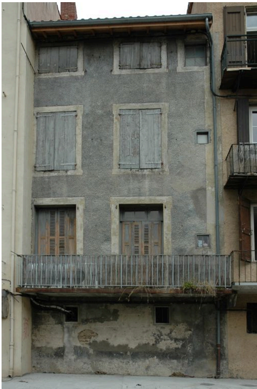
Elévation postérieure sur la rue Tupinerie.
