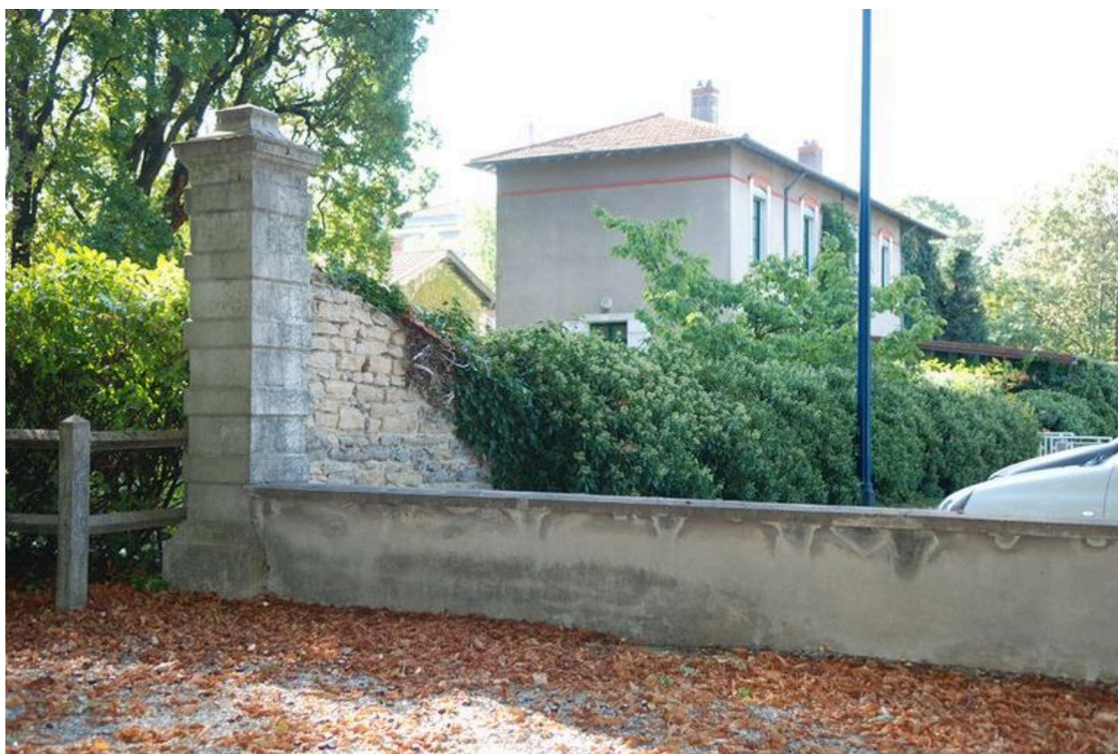
Pilier en pierre et mur d'enceinte en moellons construit vers 1894-1897, et pavillon d'habitation de 1880 environ, aujourd'hui bâtiment 222, depuis l'allée principale
