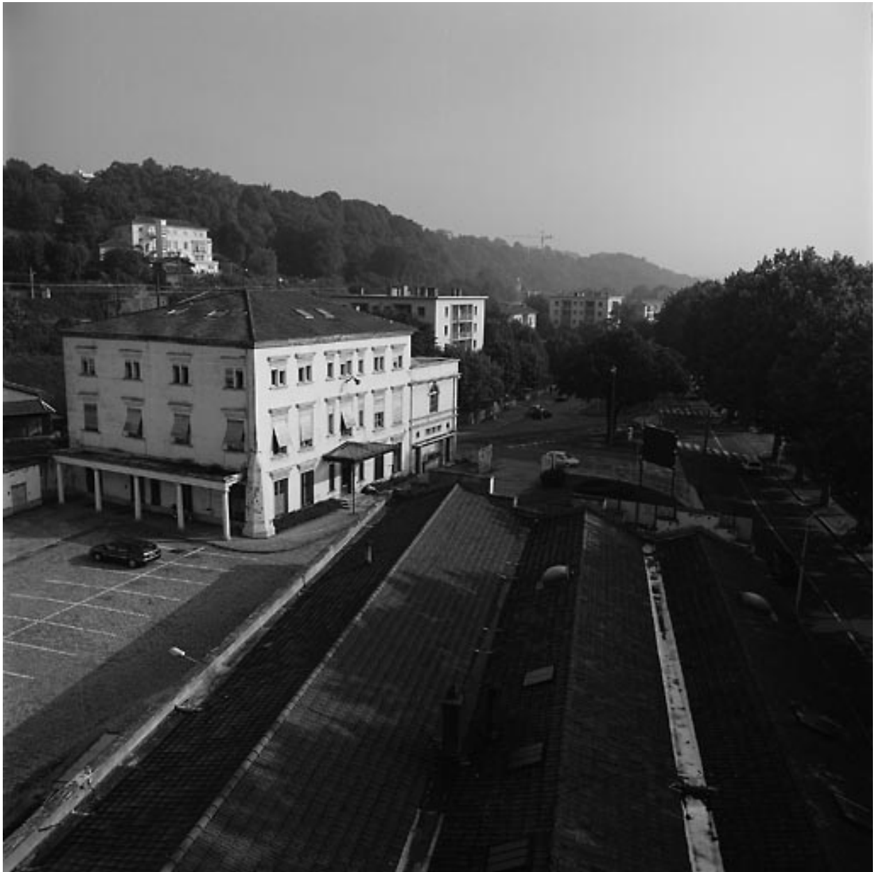
Vue sud, pavillon directorial, ancienne maison des sablières
