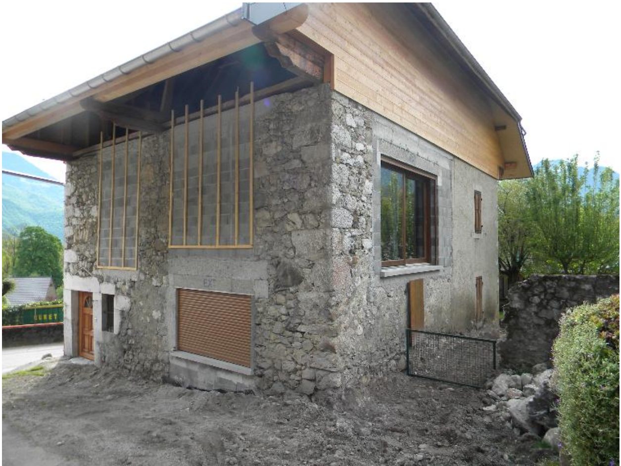
Vue de trois quarts d'une ancienne grange transformée (2008 A5 834).
