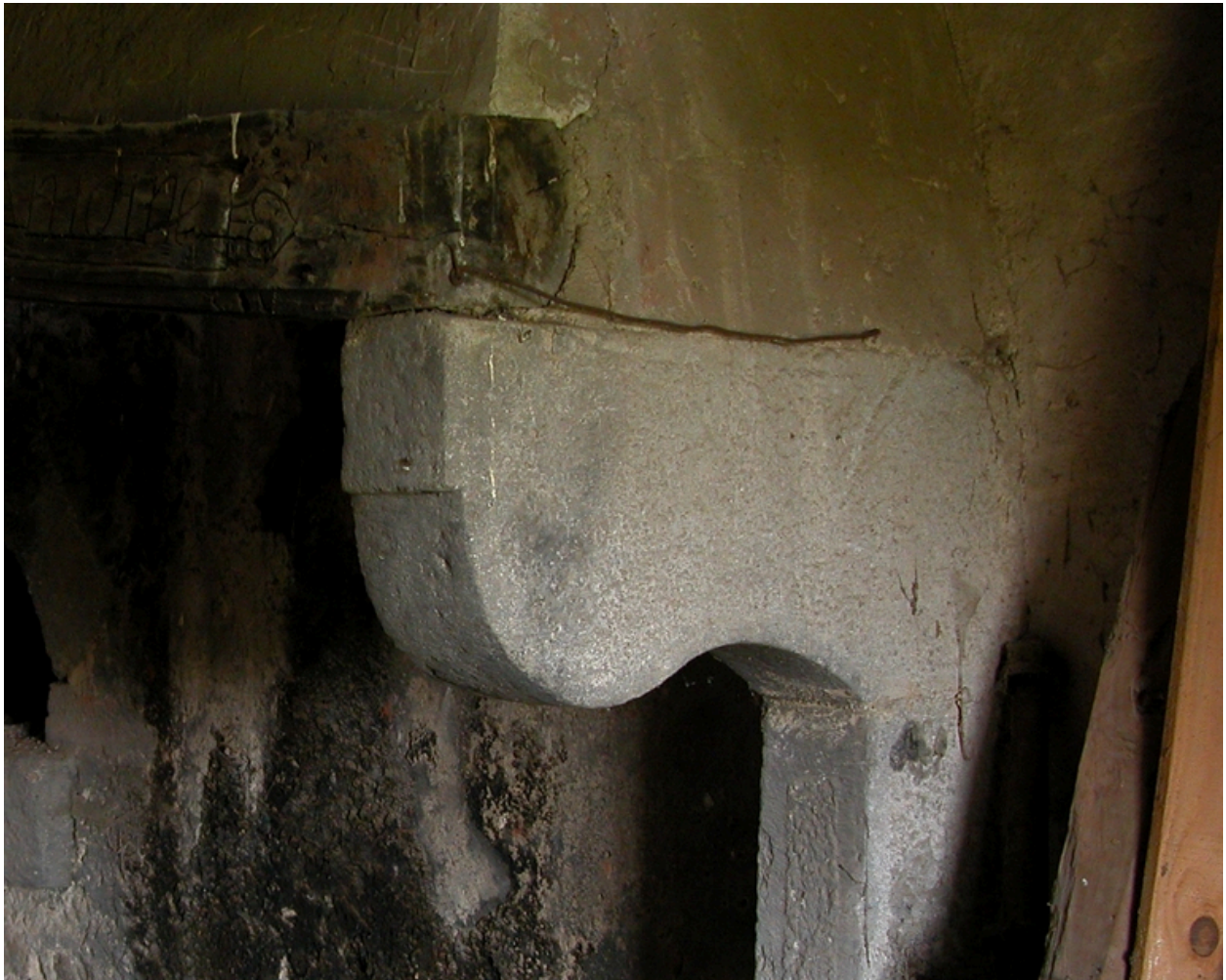
Détail de la console de la cheminée de la cuisine.
