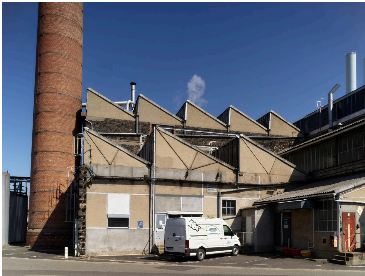
Le bâtiment B50 de la chaufferie et l'une des cheminées encore en place.
