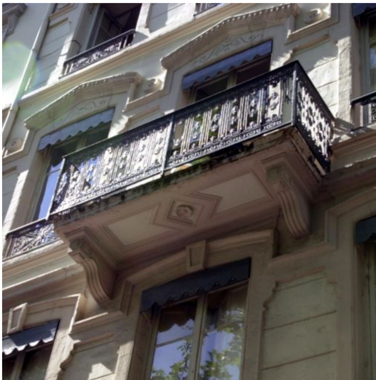
Détail du balcon
