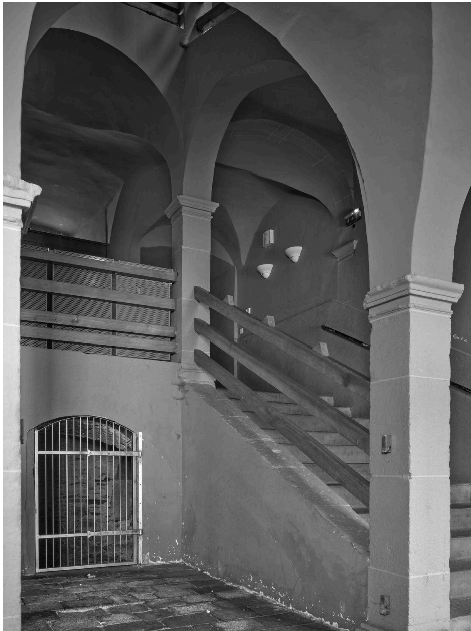
Escalier principal : départ
