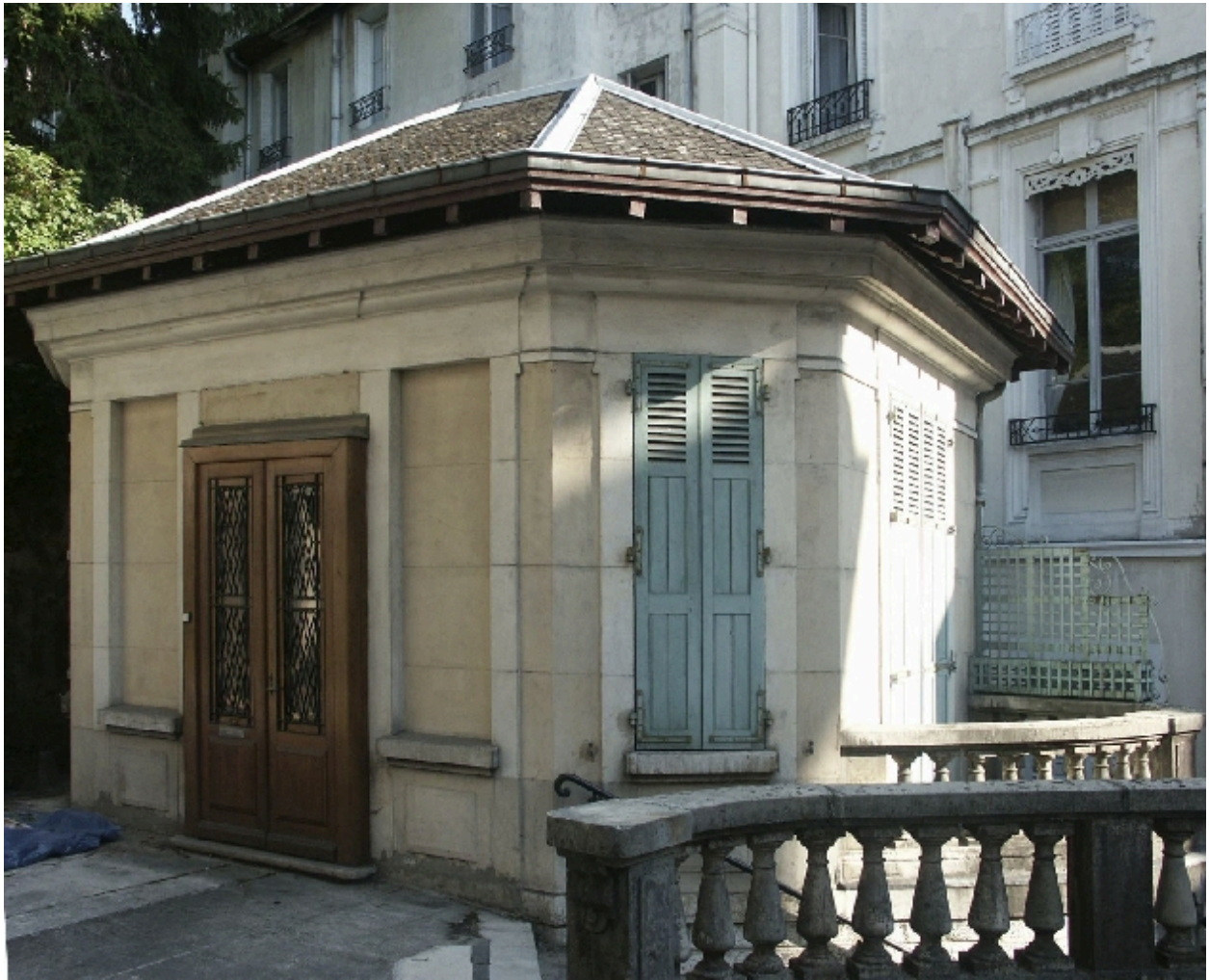
Pavillon construit sur la terrasse
