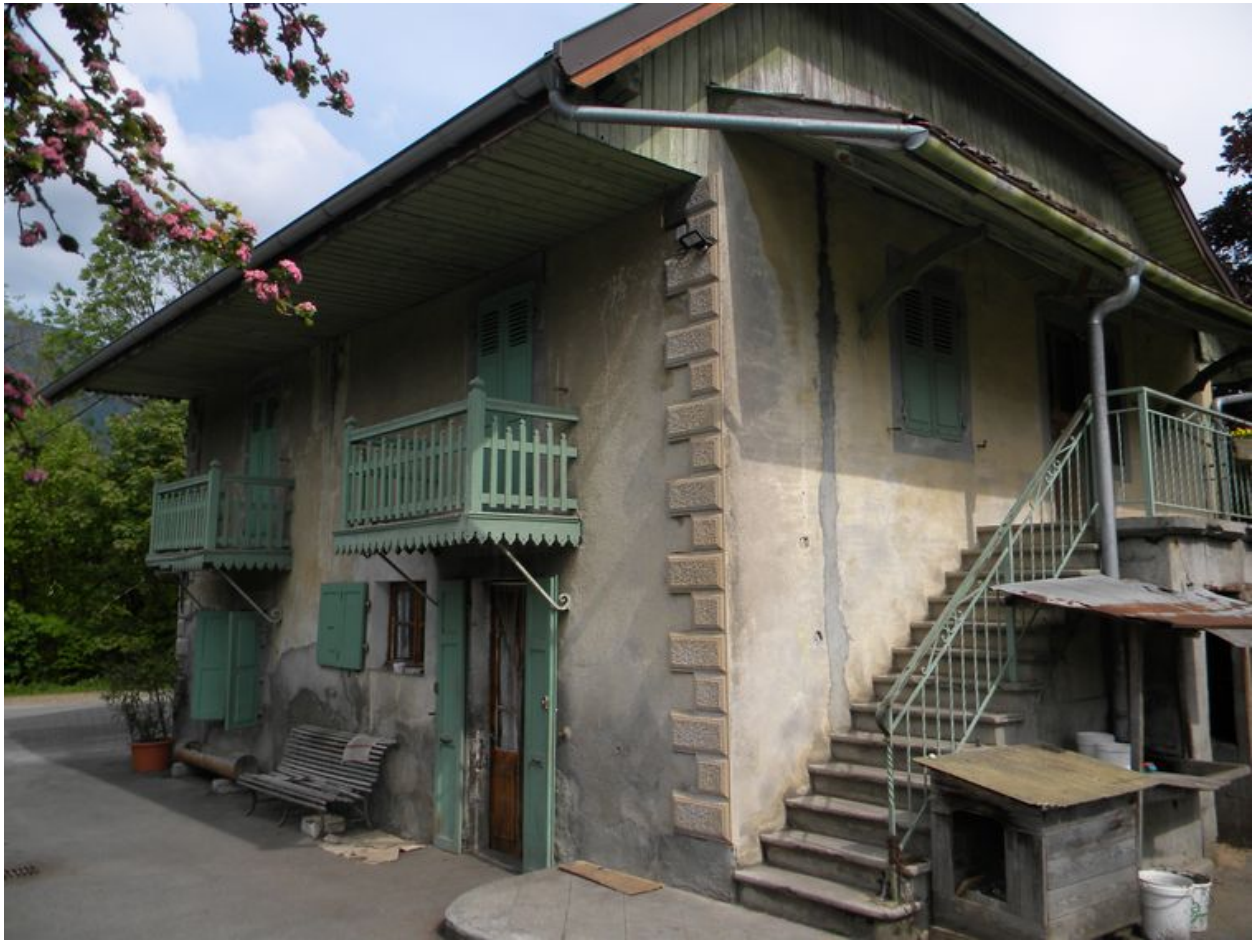
Façade sud d'une habitation de ferme à l'architecture éclectique (B7 821).
