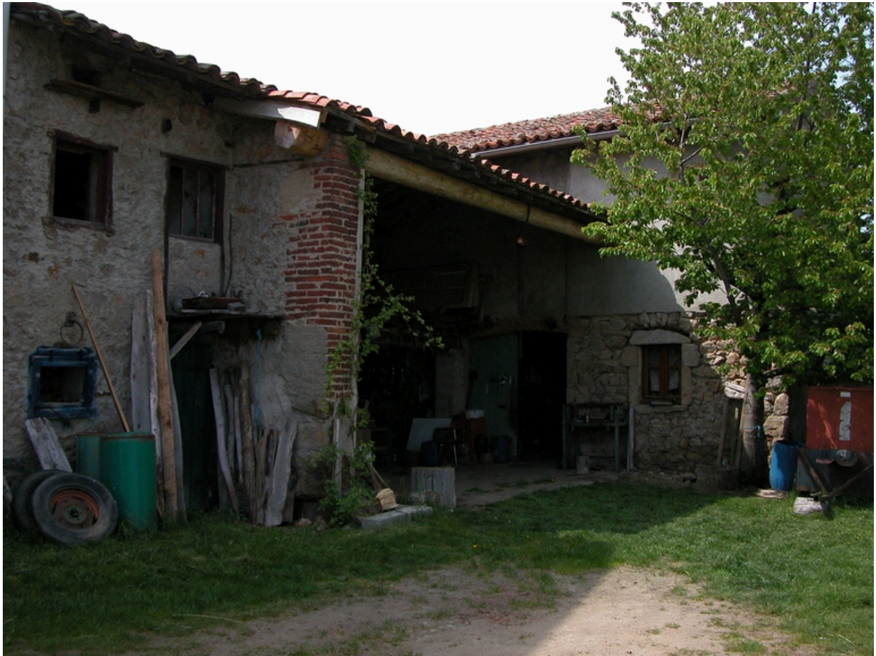
Vue d'ensemble du logis, cuvage, remise et porcherie.
