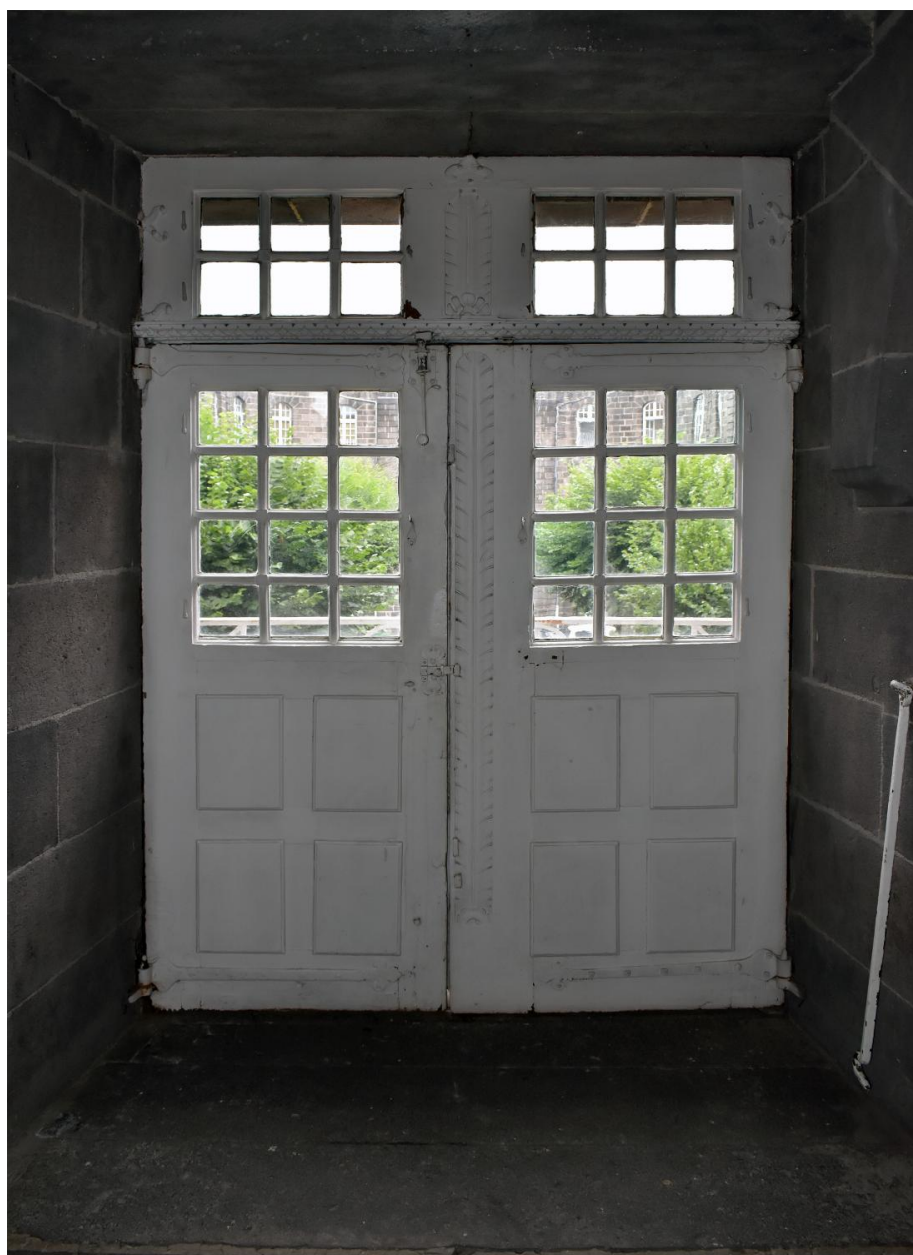
Escalier A, palier du 3e étage : fenêtre, vue intérieure
