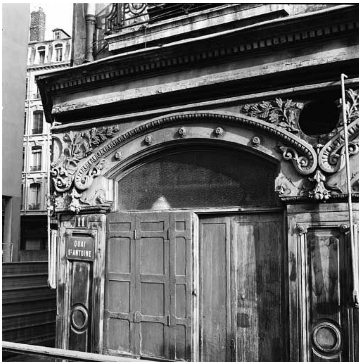
Façade principale, détail d'une ouverture de boutique à gauche de la porte
