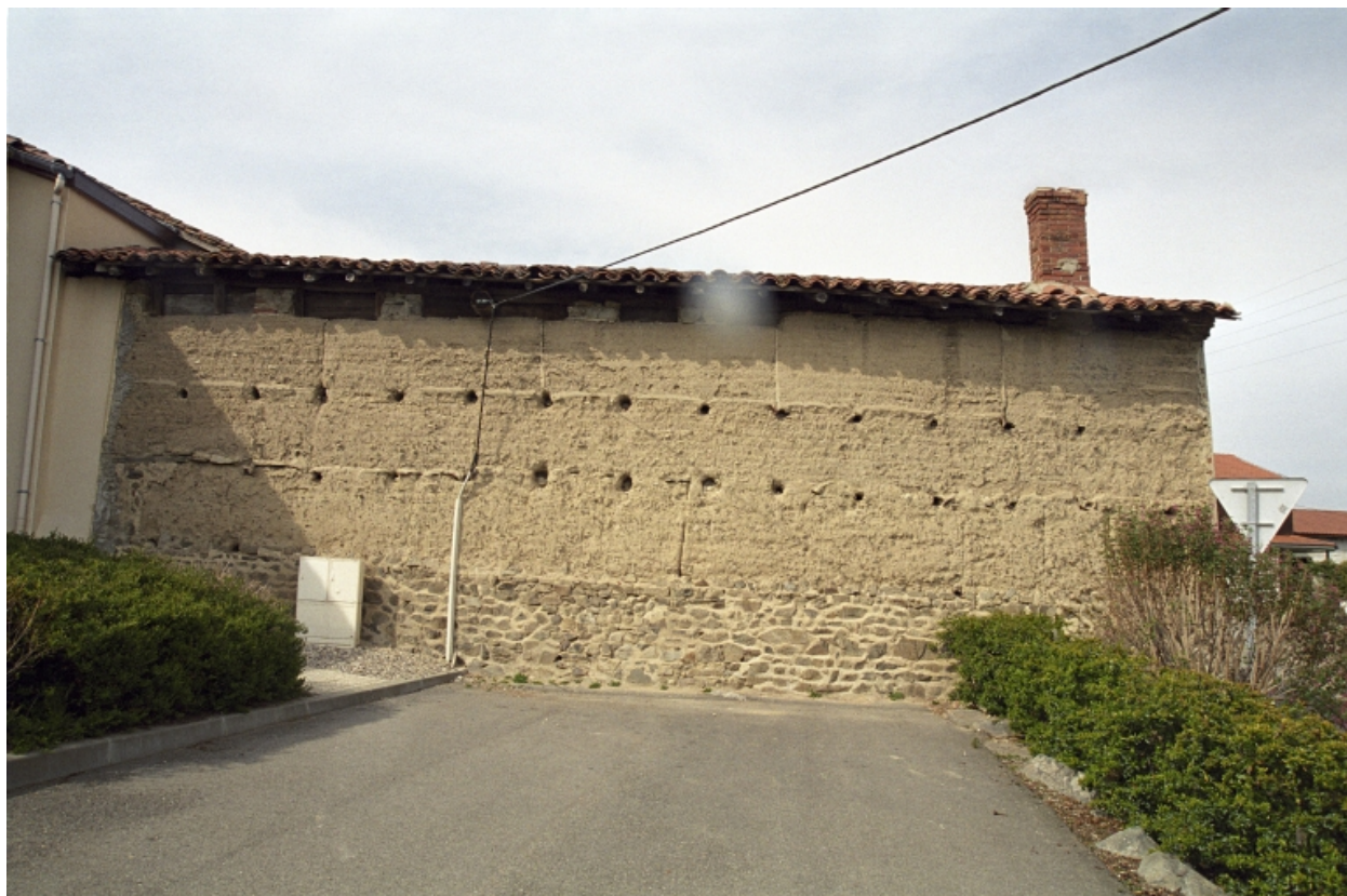
Saint-Sixte, le bourg, ferme (1987 A1 85). Élévation postérieure (milieu 19e siècle).
