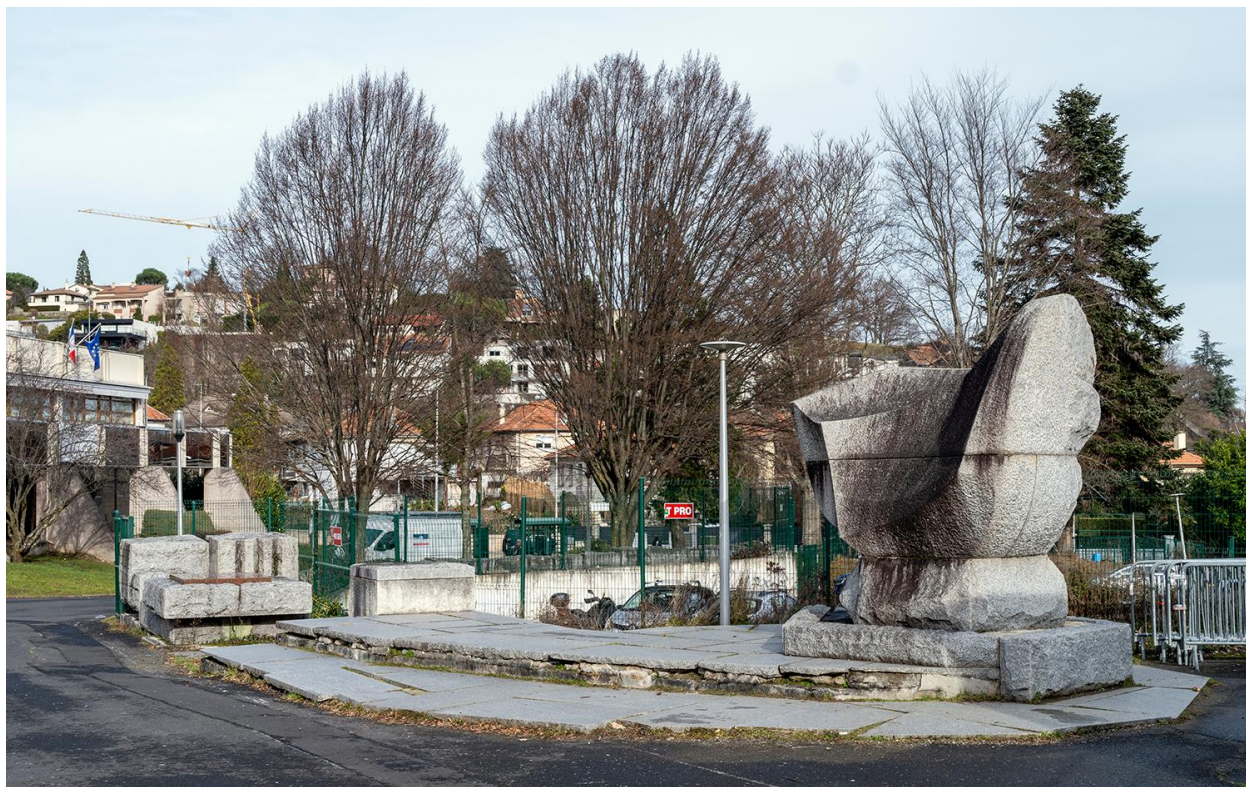
Vue d'ensemble, depuis le sud
