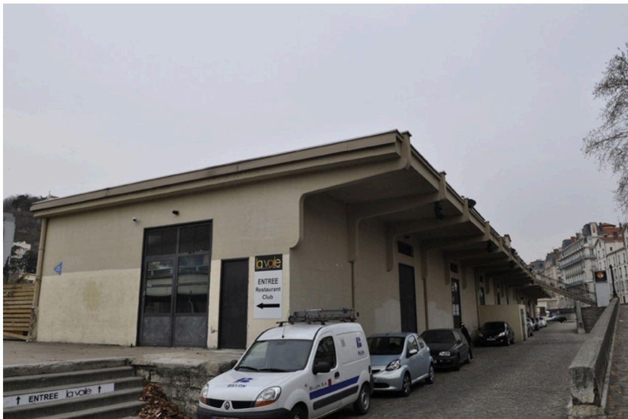
Vue sud du second bâtiment (en r-d-c)
