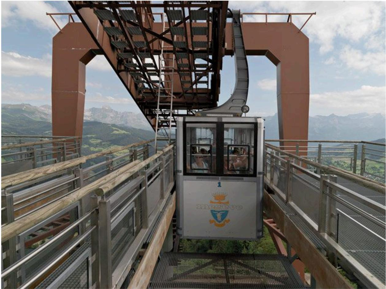
Gare supérieure. Portique et rails de portage des câbles. Arrivée de la cabine
