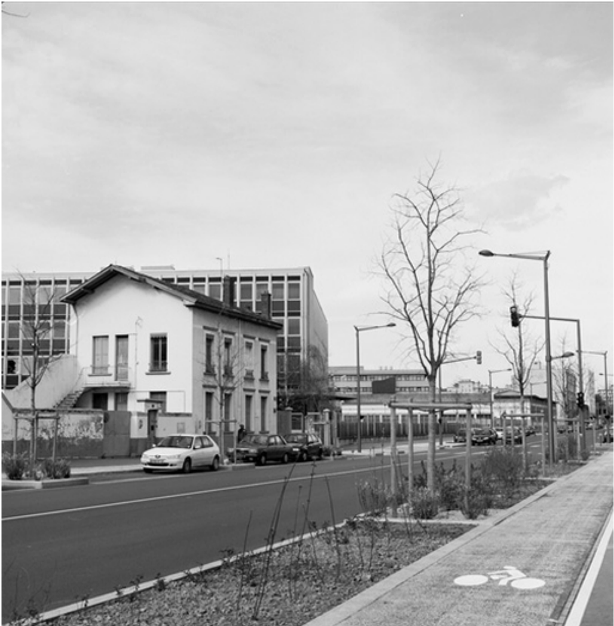
Vue d'ensemble sud-est
