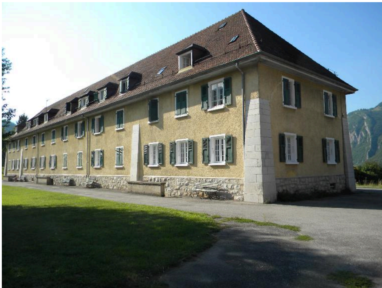
Vue de la façade arrière.
