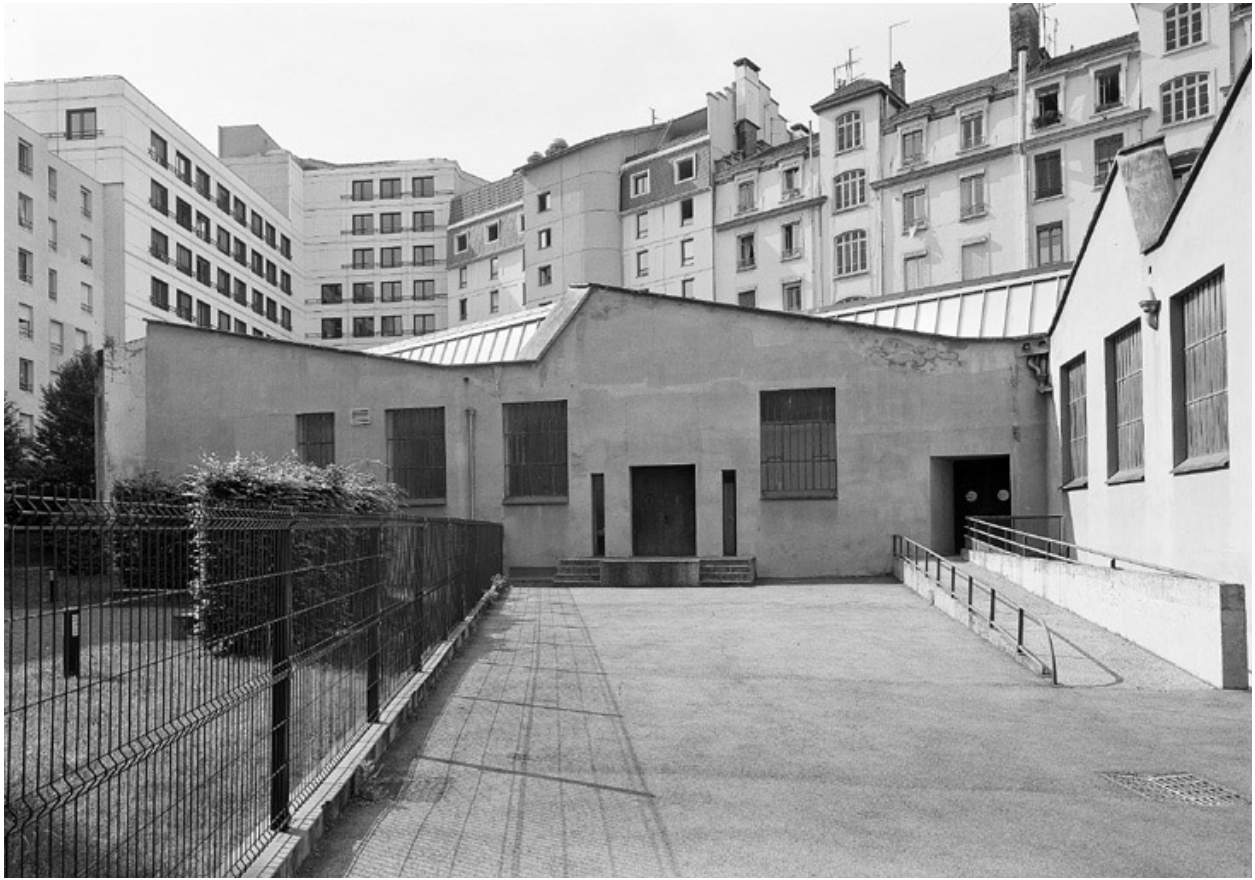
Vue nord-ouest du site
