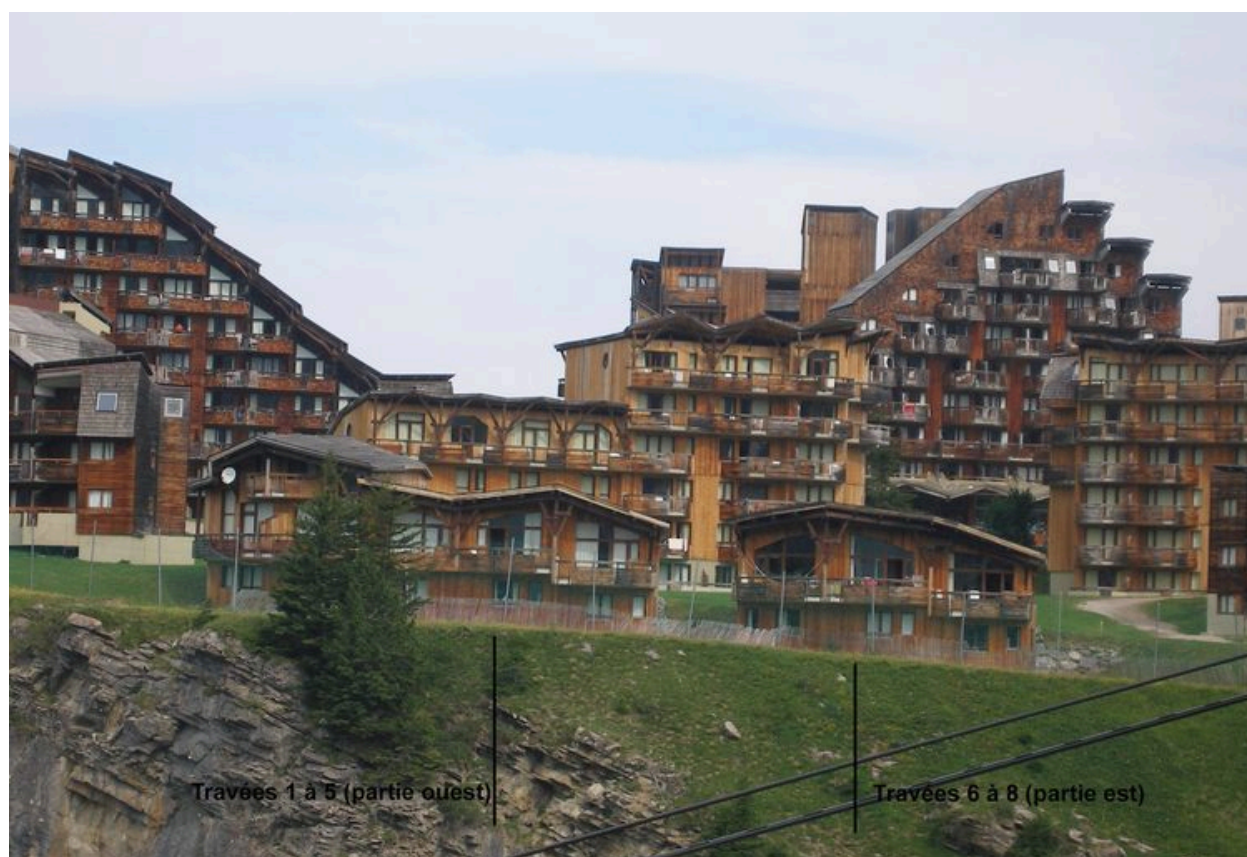
Vue depuis le sud-est
