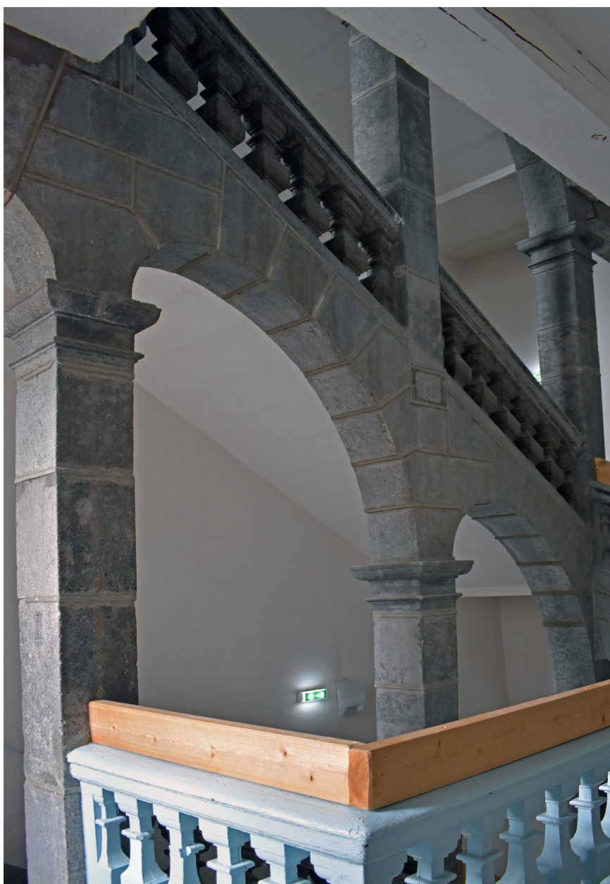
Escalier F : détail d'une volée
