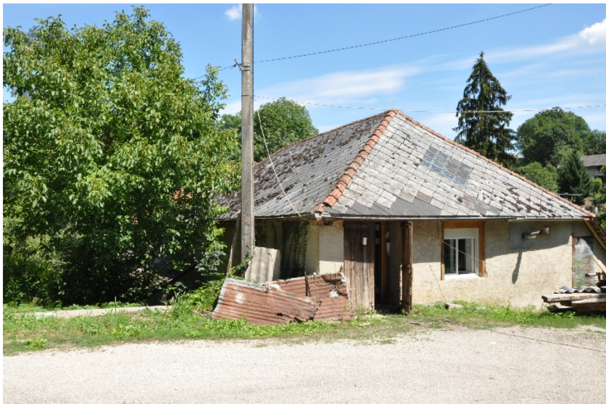
Vue de la façade sud-ouest
