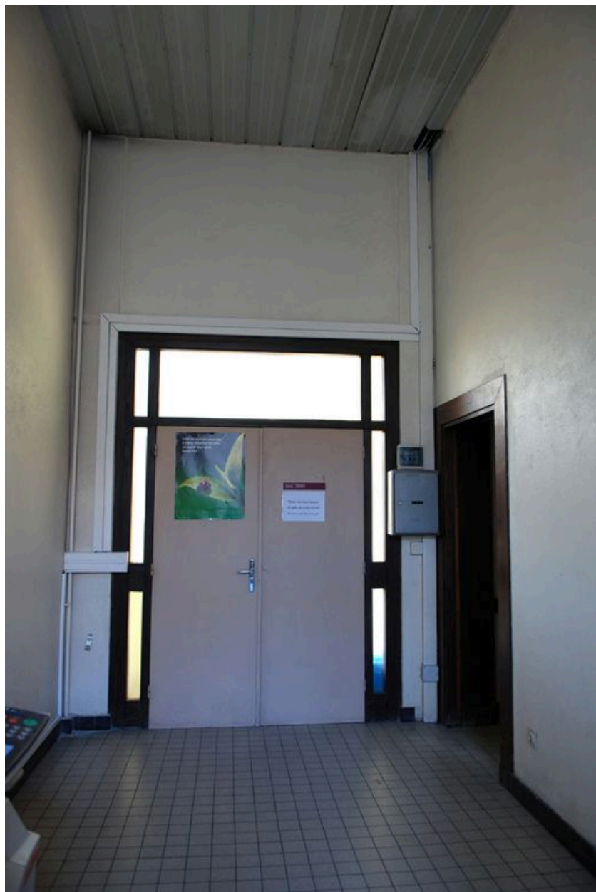
Bâtiment ISARA (2nd tranche), porte du couloir du premier étage.
