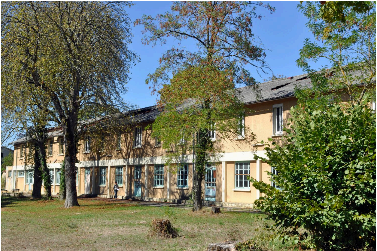
Elévation sud, vue générale
