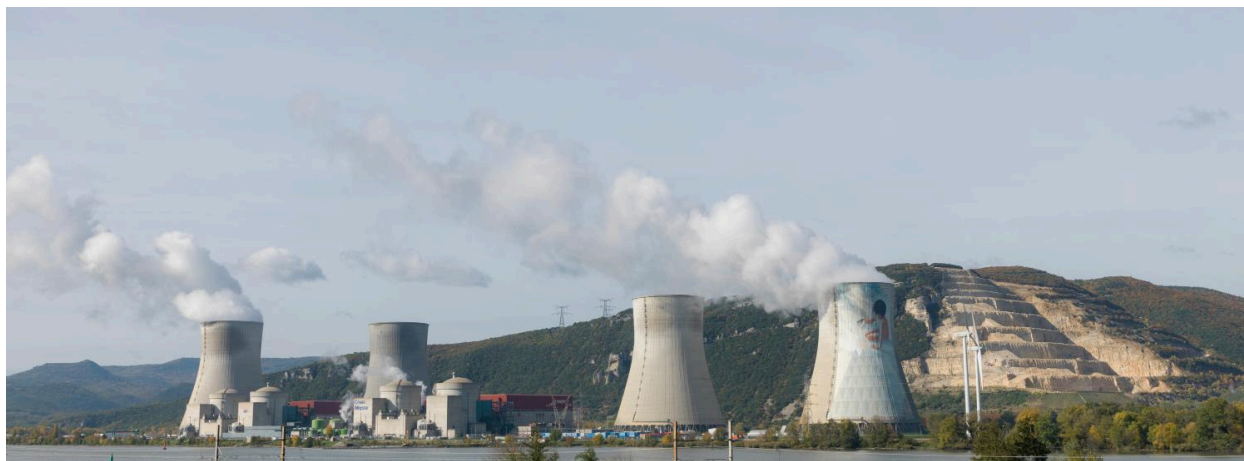
Vue d'ensemble de la centrale côté Drome
