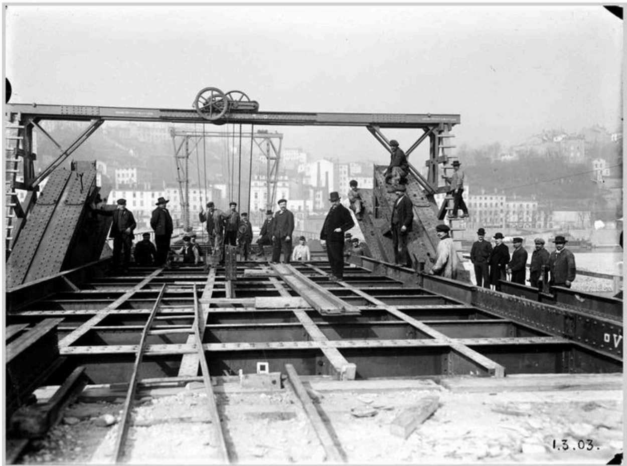
La construction du pont de la Boucle. Réunion de chantier, après la pose du tablier. 1er mars 1903. 1 fotogr. : n. et b. (AM Lyon. 15 Ph 1813)
