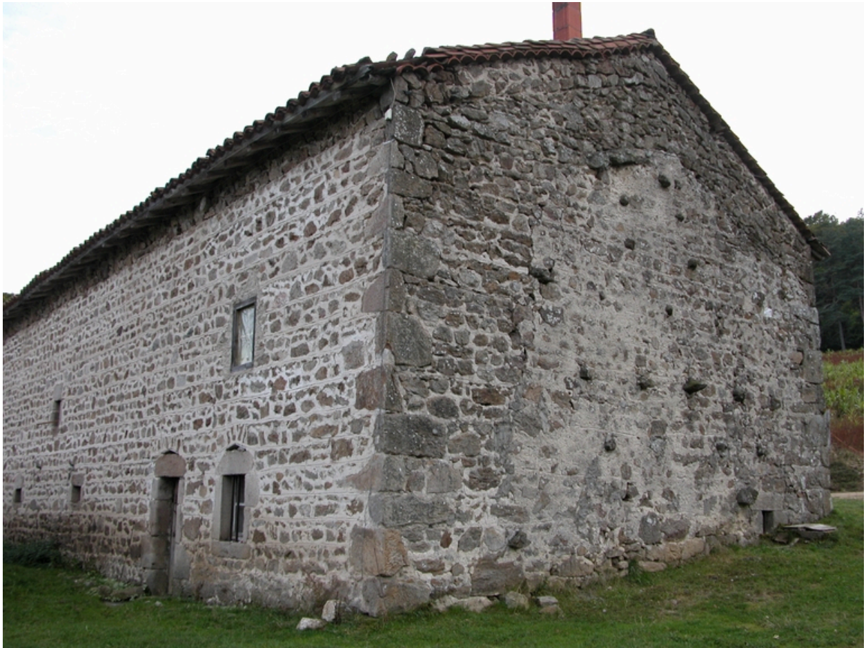
Vue d'ensemble de la façade est.
