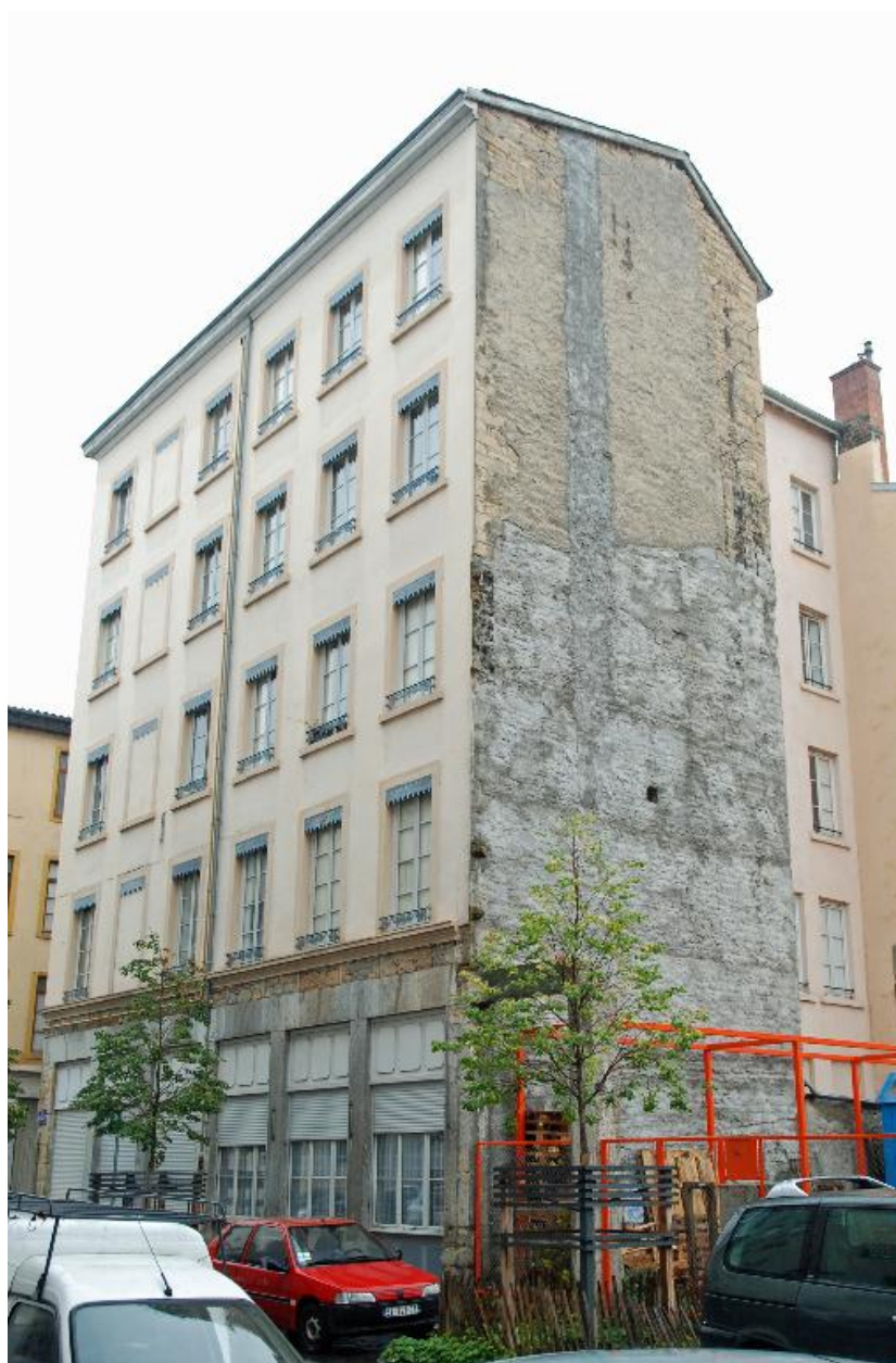
Vue latérale sud : moellons apparents sur le mur pignon
