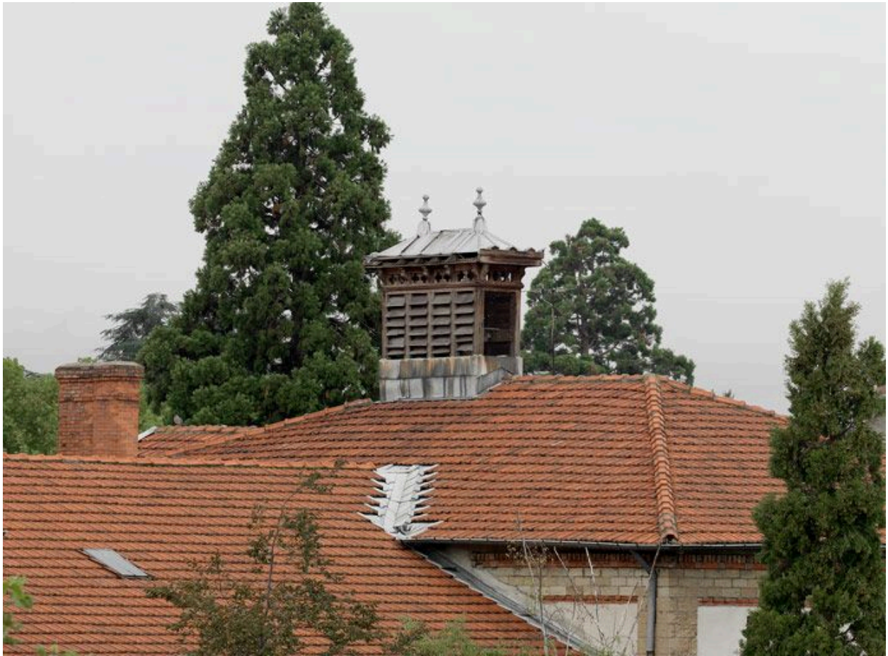
Vue depuis le sud-est du campanile en bois situé au sommet du toit de l'avant-corps central du bâtiment des services généraux
