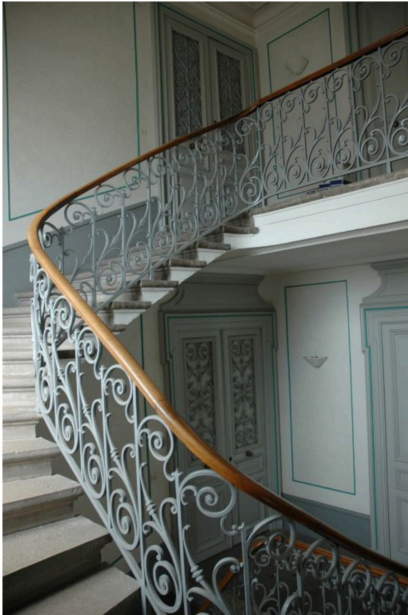
Garde-corps en ferronnerie.
