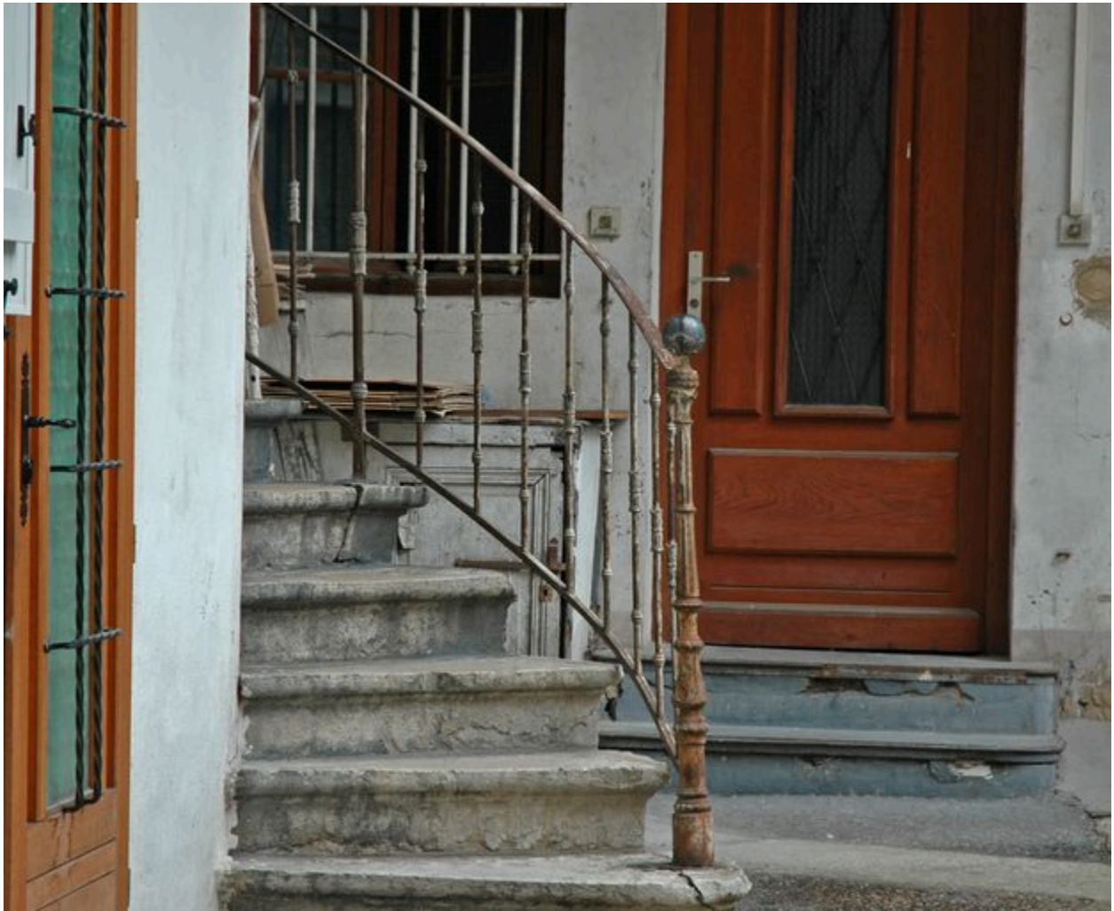
Départ de l'escalier desservant le corps de bâtiment au nord et la coursière à l'est, vue depuis l'ouest
