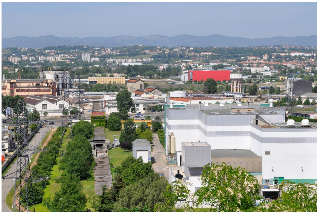
Vue d'ensemble sud-est
