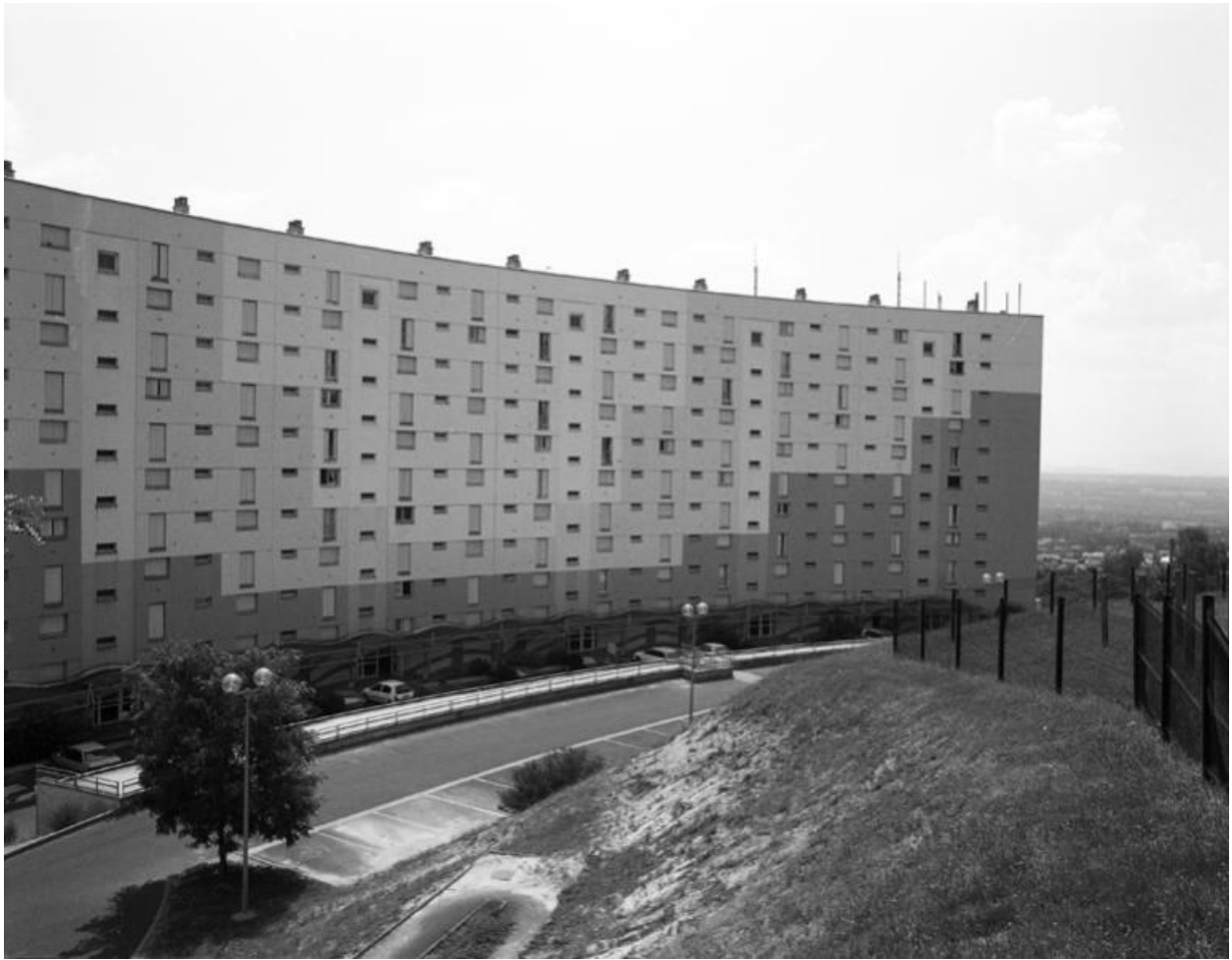
Partie ouest de l'élévation postérieure de l'ancien immeuble aujourd'hui détruit.
