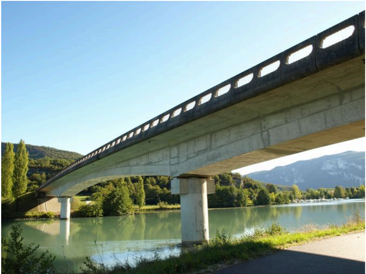
Vue partielle aval (depuis la rive gauche)
