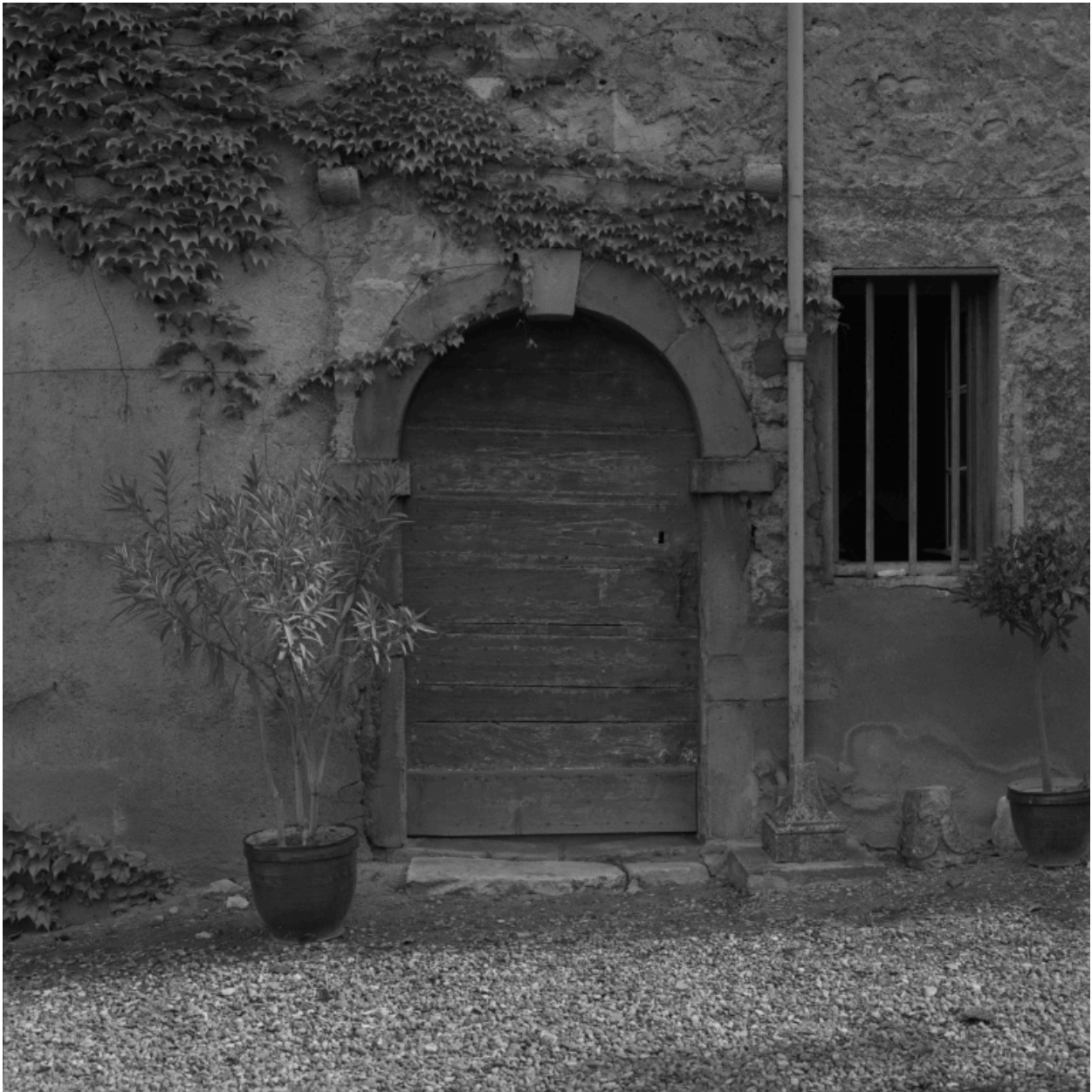
Élévation postérieure de l'aile gauche, détail : porte piétonne.
