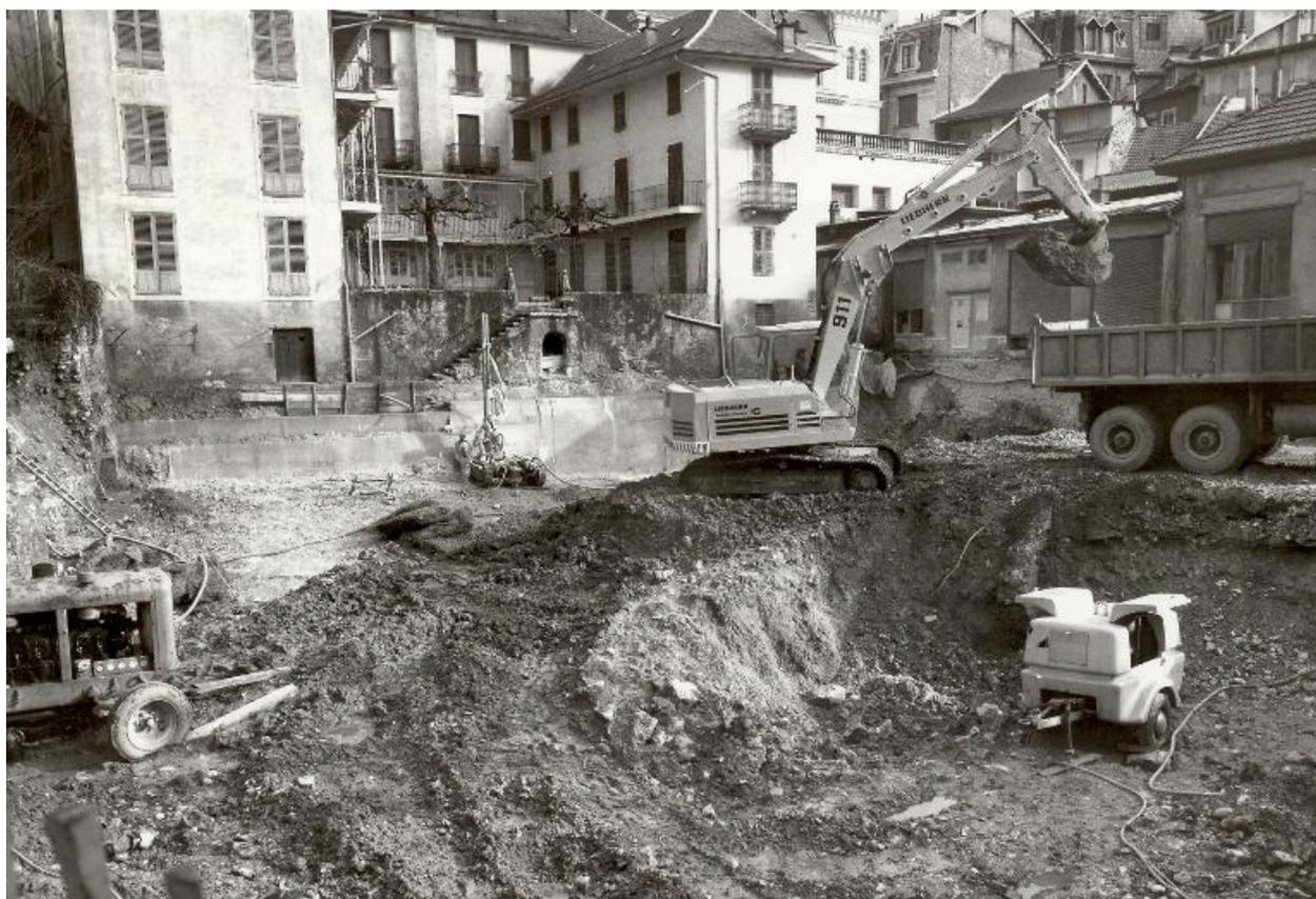
Préparation du terrain pour la construction des fondations du parking, 1979
