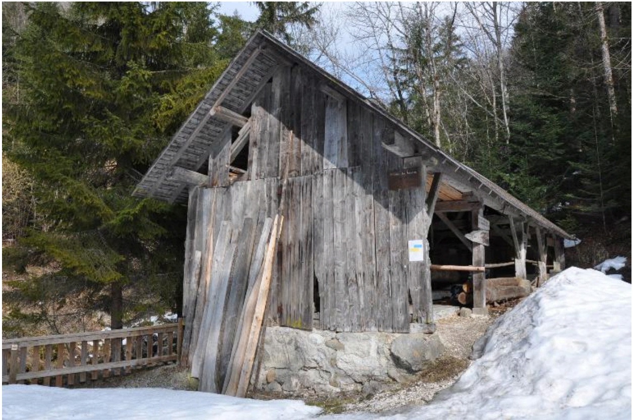
Vue du pignon ouest de la scierie.
