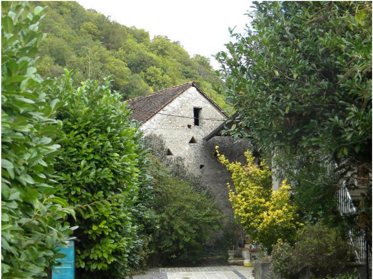
Détail d'aérations dans le pignon nord.
