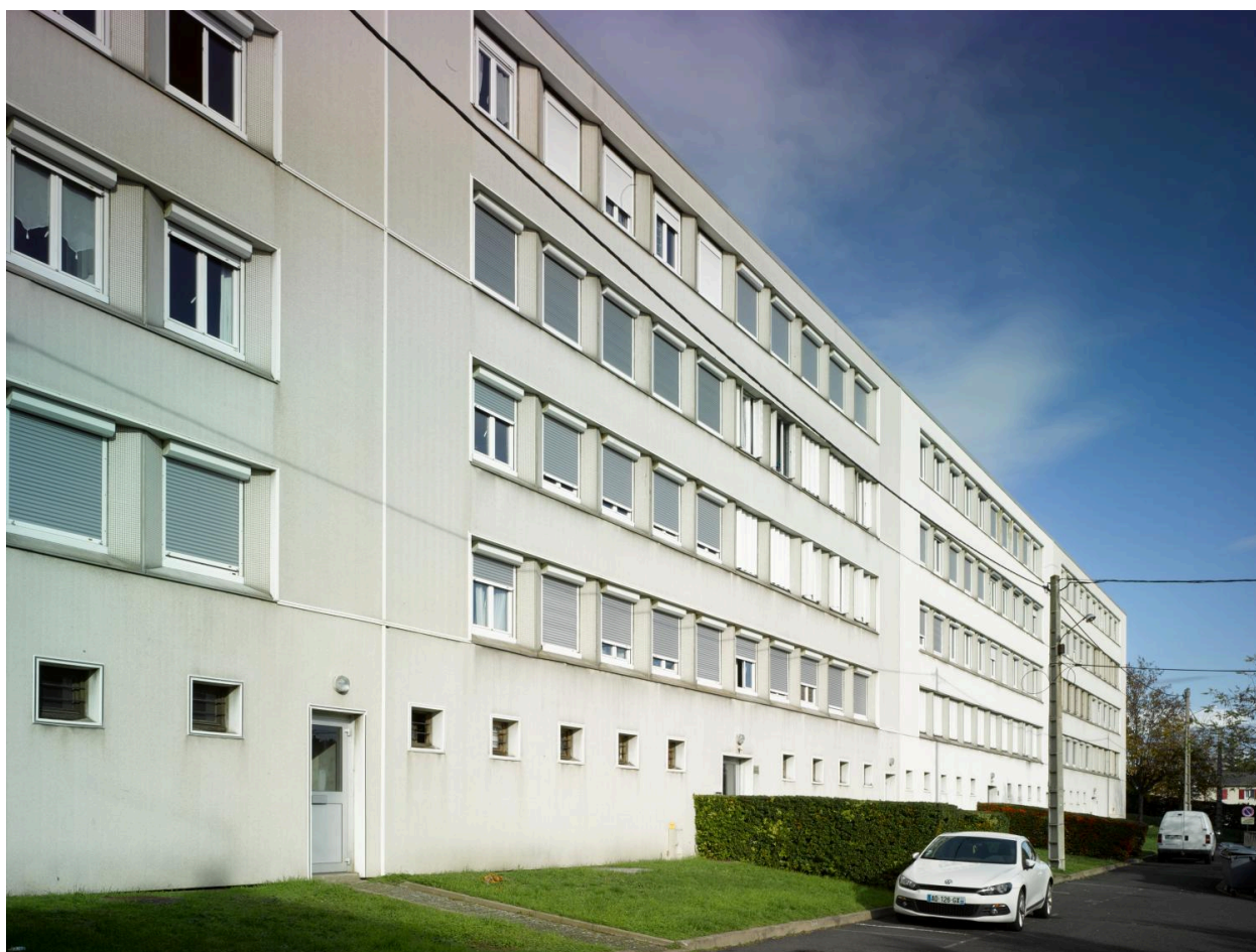
Détail du grand immeuble collectif nord-ouest : les accès depuis l'étage de soubassement.
