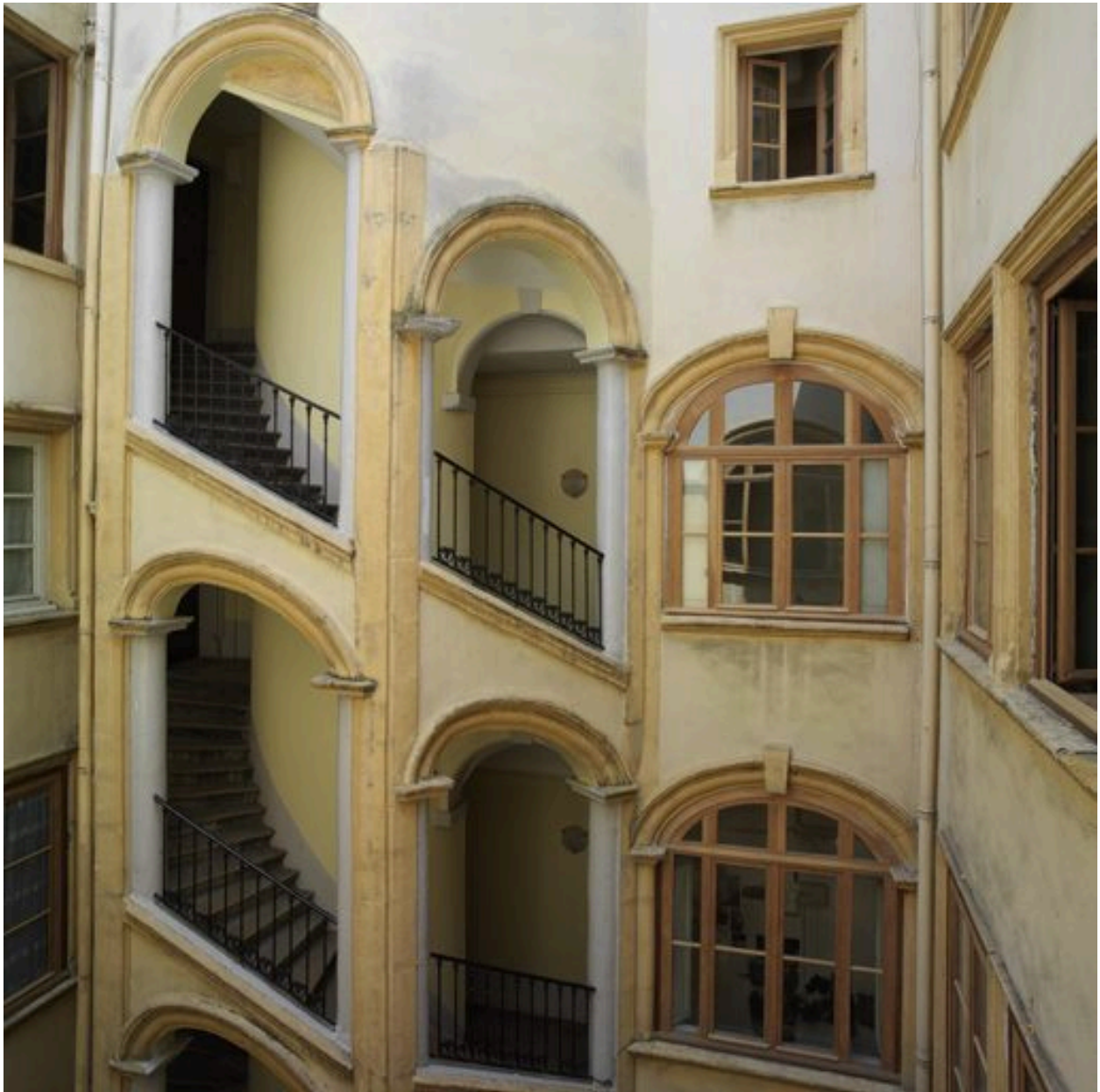
La cage d'escalier depuis le troisième étage de la galerie de liaison
