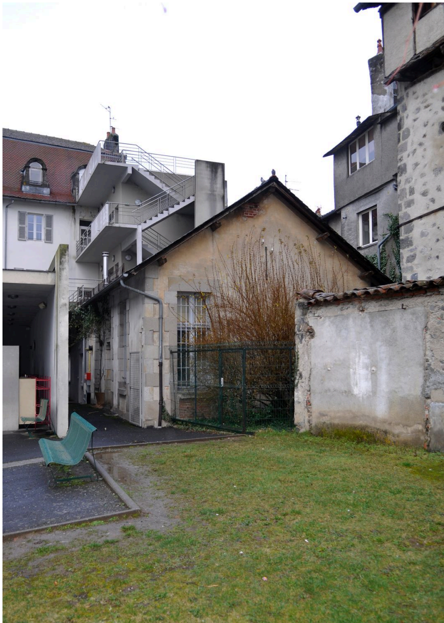
Bâtiment D : ancienne salle de classe, actuellement réserve de la cuisine
