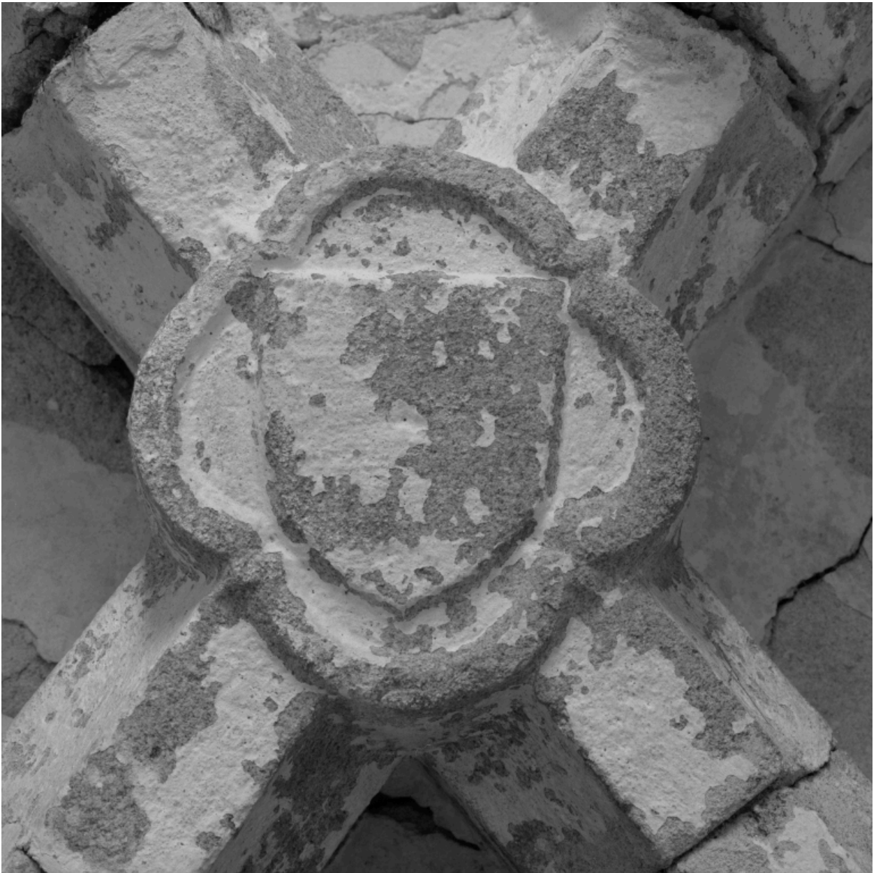
Vue intérieure de l'oratoire : détail de la clef de voûte.
