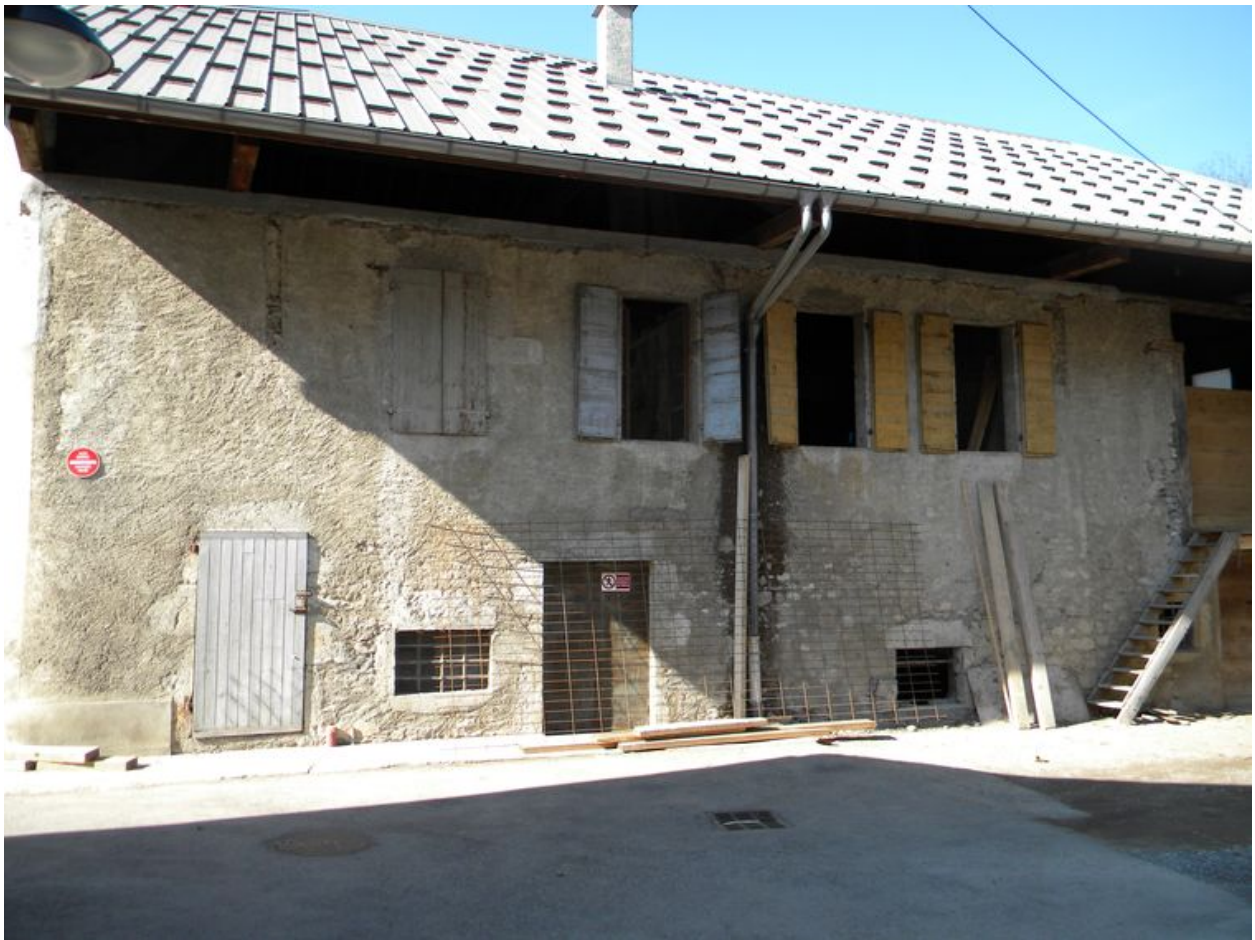
Vue de la façade sur cour d'un ancien corps de ferme qui aurait appartenu à l'abbaye de Talloires (A3 952, 953, 954, 959, 982, 983).
