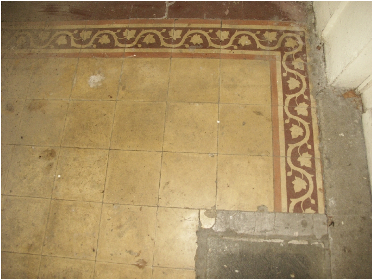
Détail du carrelage du vestibule
